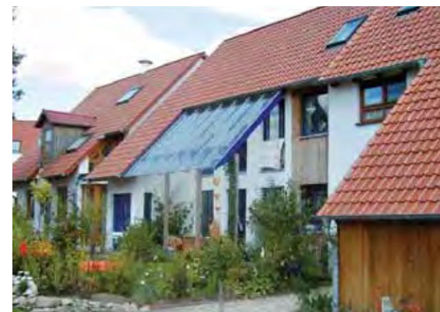
Nahwärmenetz in privater Hand, Siedlung Waldquellenweg, Architekt Bültmann, Bielefeld
